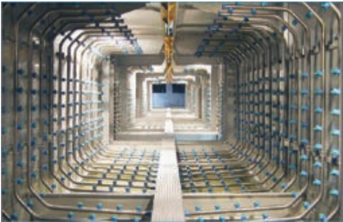
Das obige Foto zeigt eine europäische top Beschichtungsanlage
